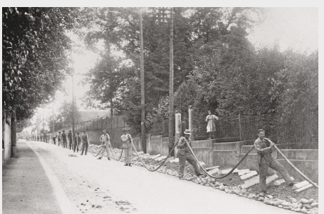
Arbeiter beim Verlegen von Erdkabeln in der Region Aarau, um 1918.
