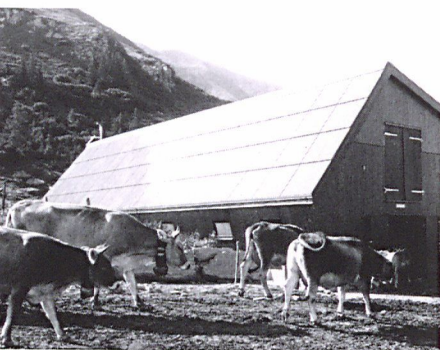
Solaranlage Alp Findels
