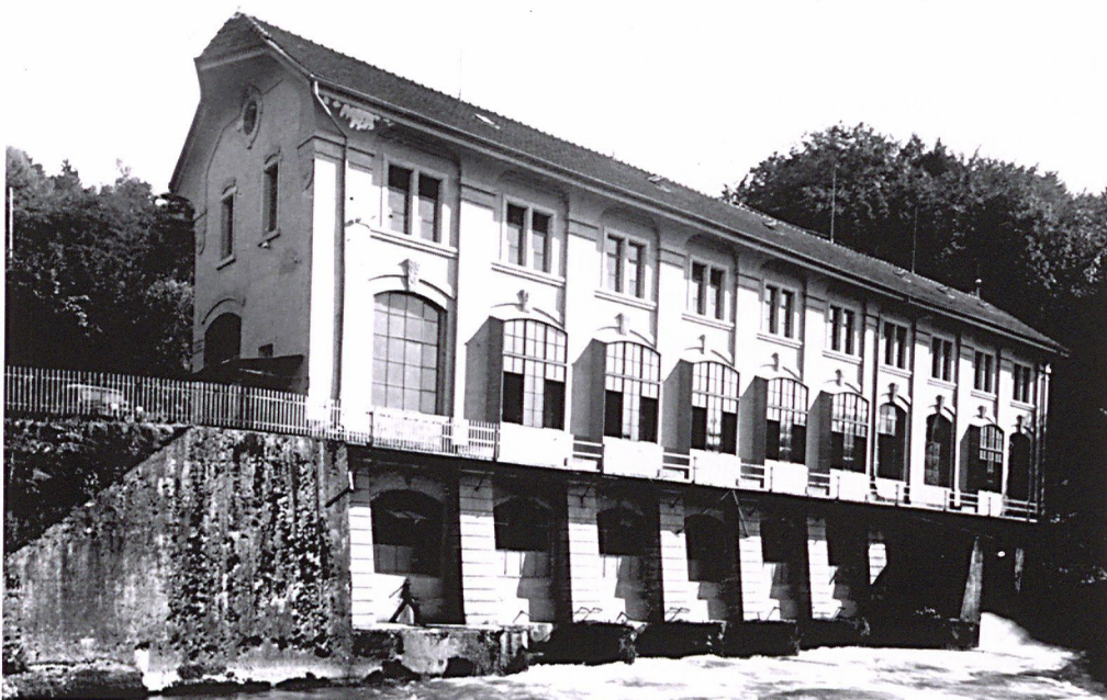
Elektrizitätswerk Zufikon-Bremgarten um 1946.
