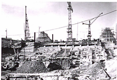
Kraftwerk Rapperswil-Auenstein. Stauwehr-Rammung der Umspannung Pfeiler 2. (29. Januar 1943)
