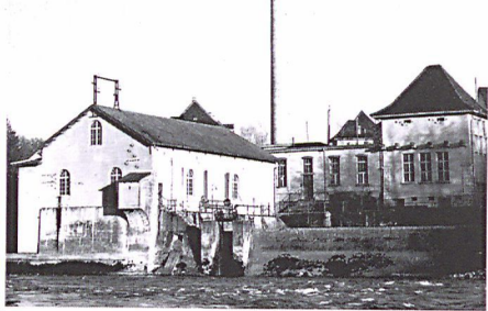
Elektrizitätswerk der Gemeinde Brugg von Nordwesten her. In der Mitte mit Hochkamin die Dampfmaschinenanlage, rechts die Schaltanlage.
