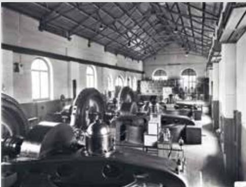
2-phasige Generatoren im Kraftwerk Kappelerhof in Baden, erbaut 1891/92, umgebaut 1925 (Bild), 1974–1976 und 2003–2006.
